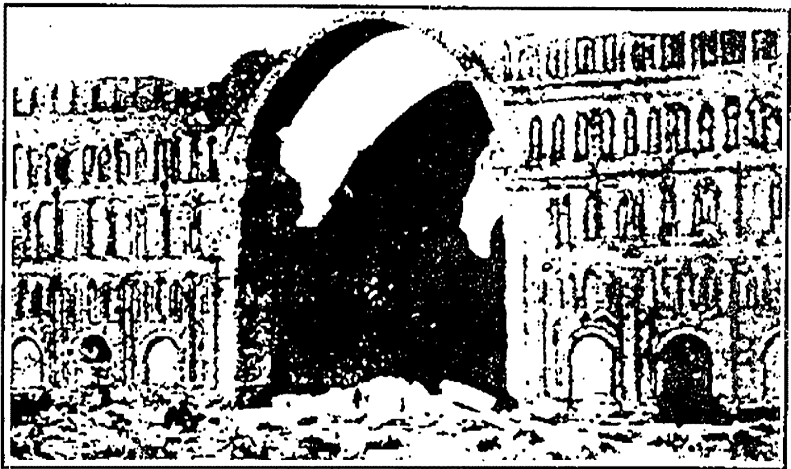
شكل (٦) واجهة إيوان المدائن
